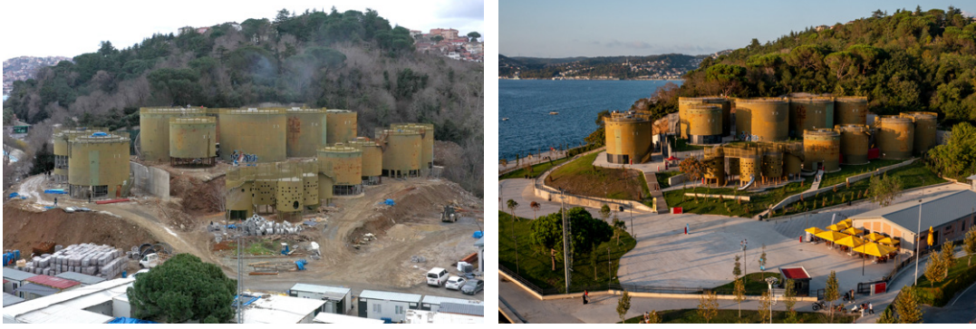
Fotoğraf 3. Beykoz Çubuklu Silolar Eski ve Yeni Hali (2022-2024)
