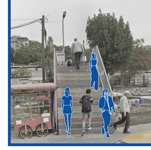
5 Eski ve yetersiz köprü
