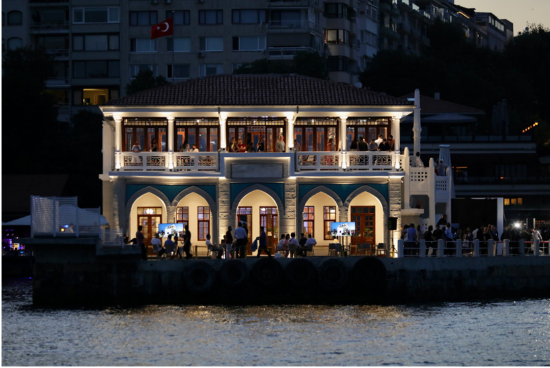
Resim 1. Restorasyon Sonrası Moda İskelesi
